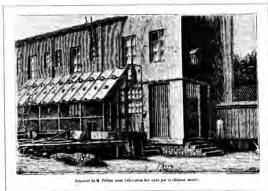
Figure 2. Appareil de M. Tellier pour l'élevation des eaux par la chaleur solaire. (Source : Charles Tellier, « Utilisation de la chaleur solaire pour l'élevation des eaux », La Nature , 1885, 13 e année, 2 e semestre, p. 221.)
